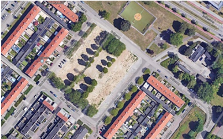
Gesloopte rijtjeswoningen in de Schutskamp te 's-Hertogenbosch, een bouwrijp terrein voor specifieke nieuwbouw
